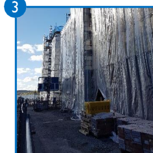
På ställningsetapper där det finns risk att personer träffas av fallande föremål ska alltid minst nät/sommarväv monteras.
