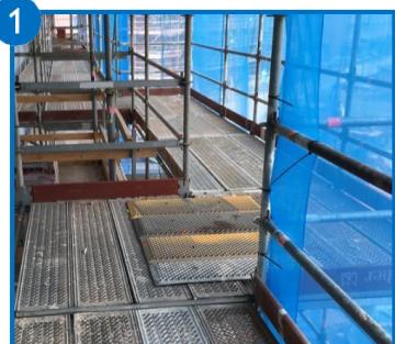
Skarvning av ställning ska utföras med godkänt och lämpligt ställningsmaterial. Hållrum mellan ställningsdelar får ej överstiga 50 mm.
