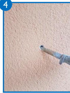
Använd kniv runt ställningsinfästning för att skapa ett runt hål.
