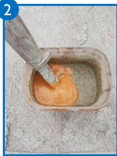
Tillsätt fasadens färg till det färdigblandade putsbruket.
