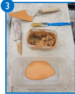
Förbered med en murslev, kniv, pensel, fasadfärgat putsbruk och fasadfärg.
